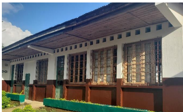
L'école ménagère repeinte, avec ses nouvelles fenêtres
